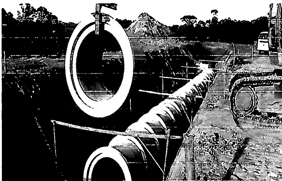
Figura 5 - Exemplo de modelo de tubulação para drenagem
