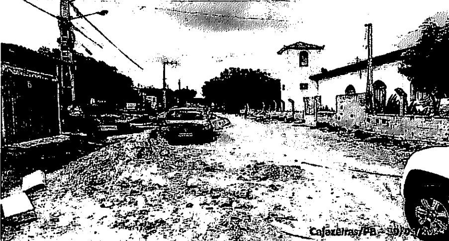
BM 04 - Contrato de Repasse 834700/2016 Ministério do Cidades - Implantação de Pavimentação em Vias Públicas Urbanas - Cajazeiras/PB (Rua João Bernardo de Oliveira - Regularização + Nivelamento)
