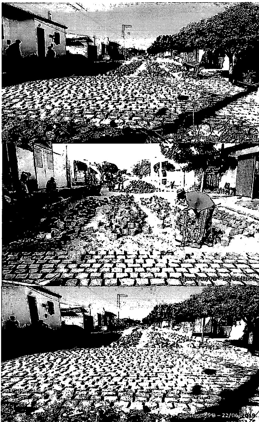
BM 04 - Contrato de Repasse 834700/2016 Ministério do Cidades - implantação de Pavimentação em Vias Públicas Urbanas - Cajazeiras/PB (Rua João Bernardo de Oliveira - Pavimentação)
